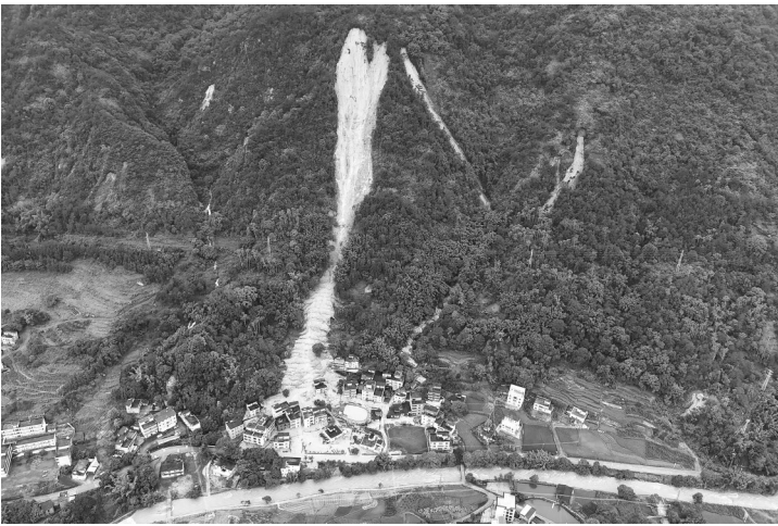
航拍联二村山体滑坡现场。通讯员 雷甲源 摄
