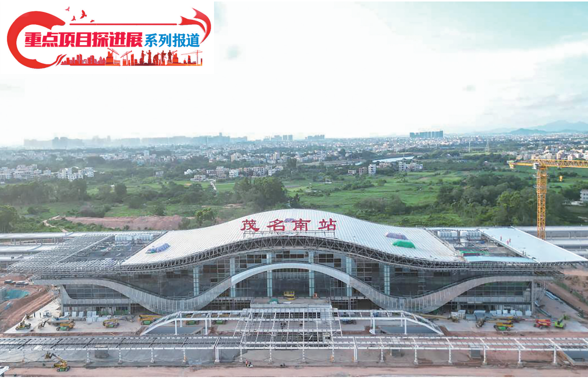
茂名南站站房项目施工现场。
