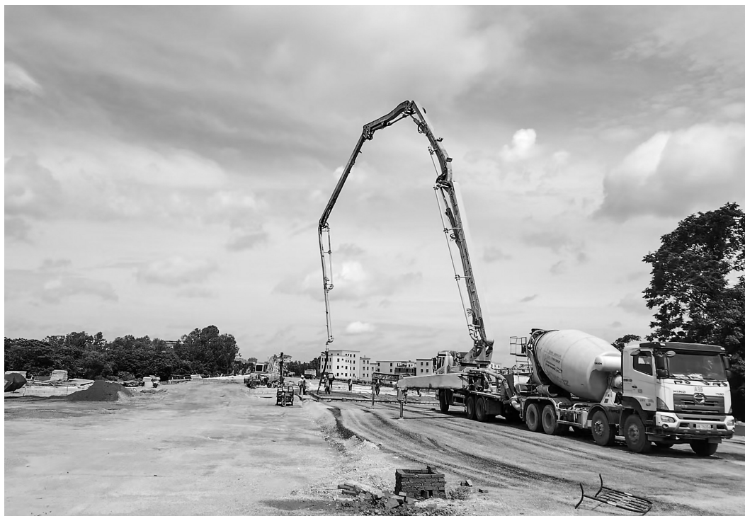
剩余路面加紧施工。
