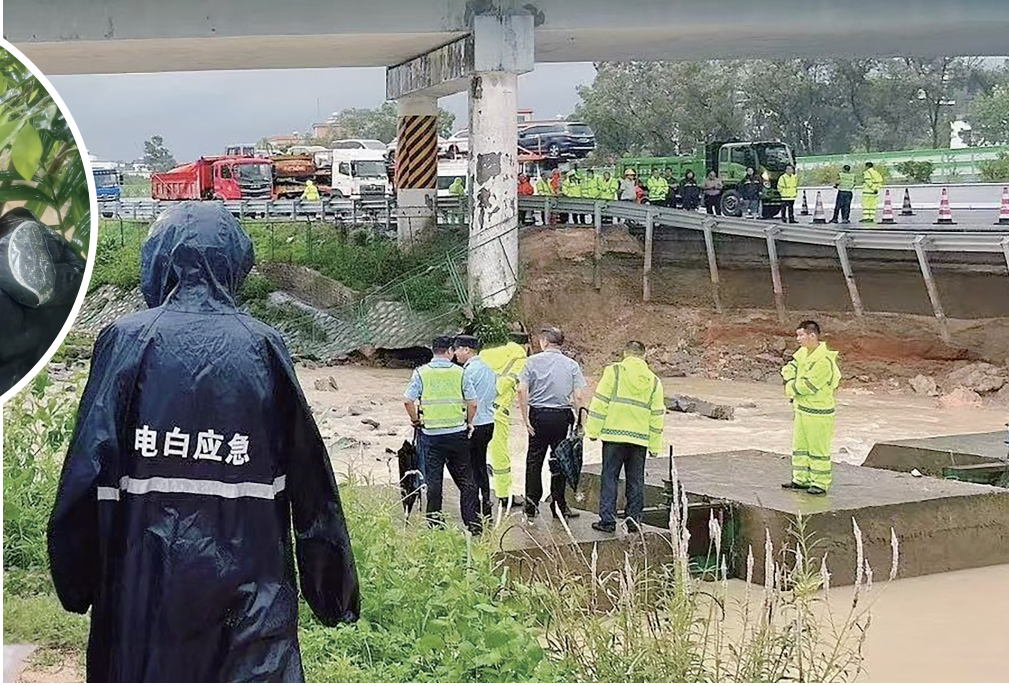
交通、应急部门紧急修补高速边坡。
