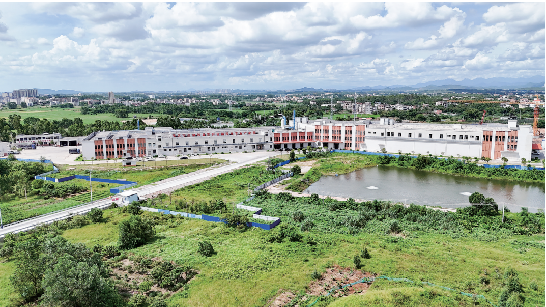
省重点项目高州市禽畜屠宰冷链加工产业基地(一期)
