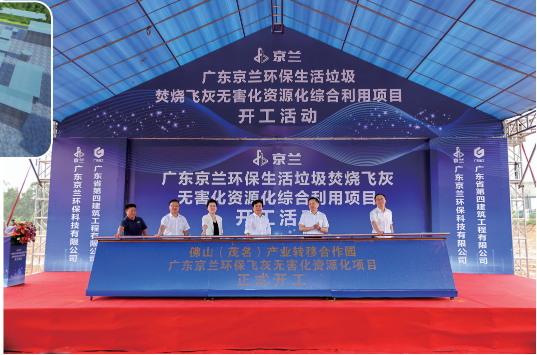
▲项目落地建设跑出“高州速度”。
