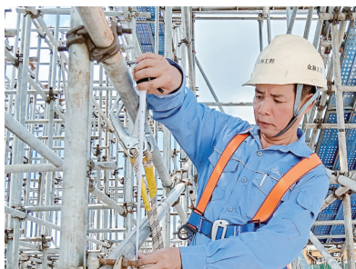
▲戴伟森,众和建总施工部现场管理。第二届众和好人、众和公司HSE标兵。
