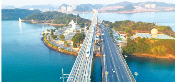
动车驶过防城港西湾跨海大桥
