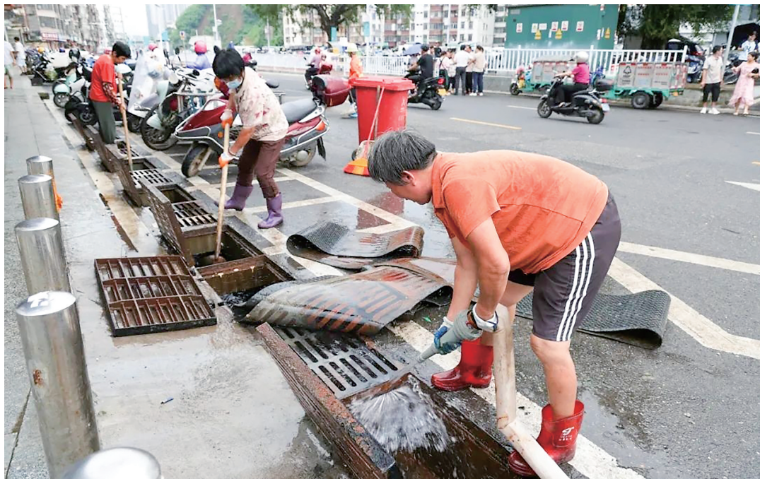
当地锦江市场排水沟“三清一灭”工作现场。
