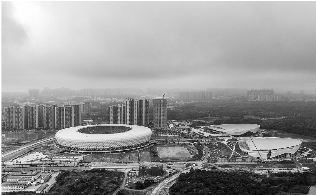
奥体中心正在建设中。
