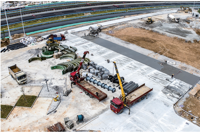
高州服务区建设现场
