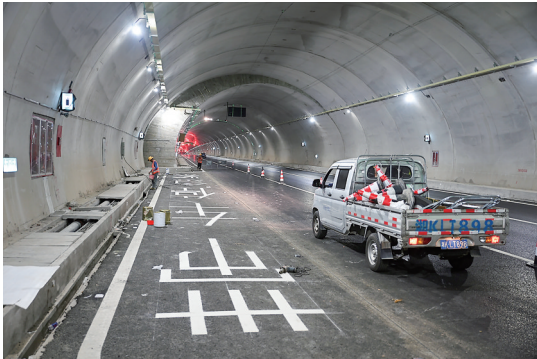
隧道里,工人正在进行最后的修补工作。
