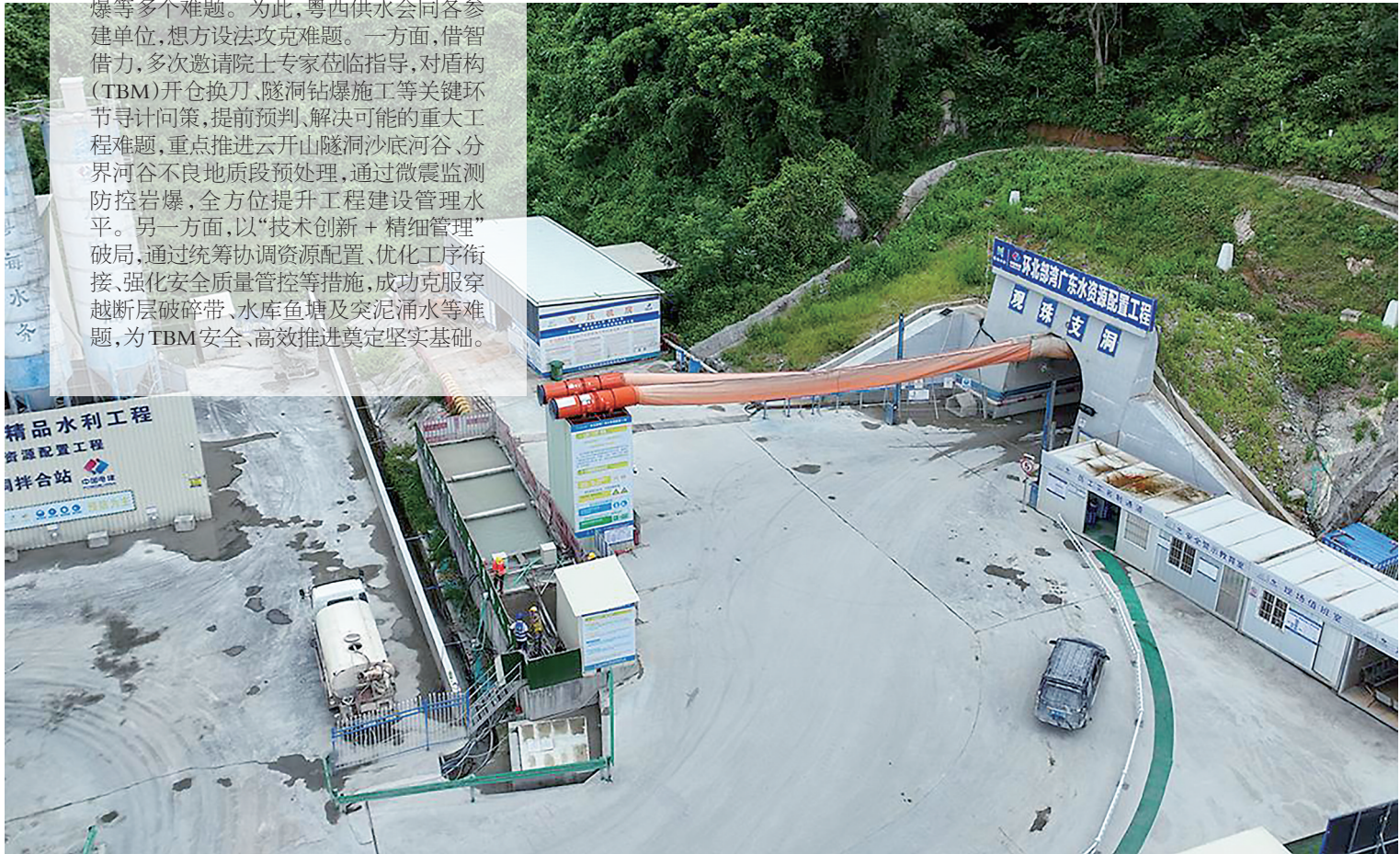
观珠隧洞洞口。
