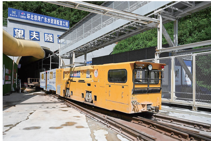
望夫出口TBM11“追赶号”工区“小火车”正在运输设备进洞。
