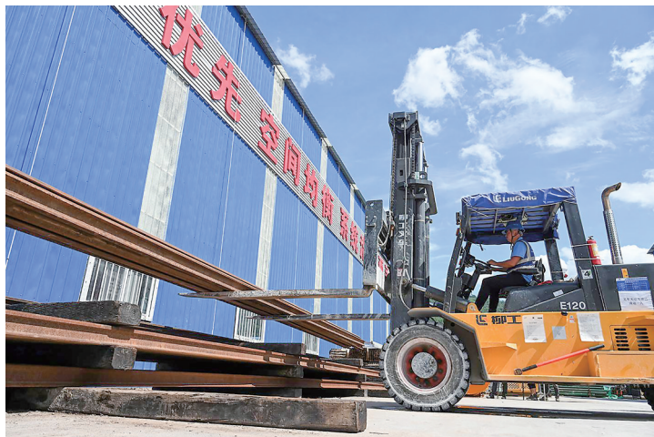
望夫出口TBM11“追赶号”工区叉车司机正在运输TBM钢轨轨道。
