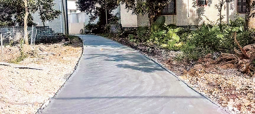
沙琅镇多处乡村道路焕然一新。
