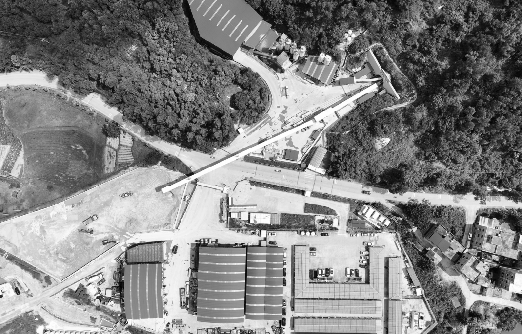
19#顶管井施工现场。茂名日报社全媒体记者 甘杨松 摄
