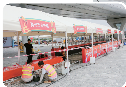
昨天,施工人员正在加紧布置特色农副产品展位。
