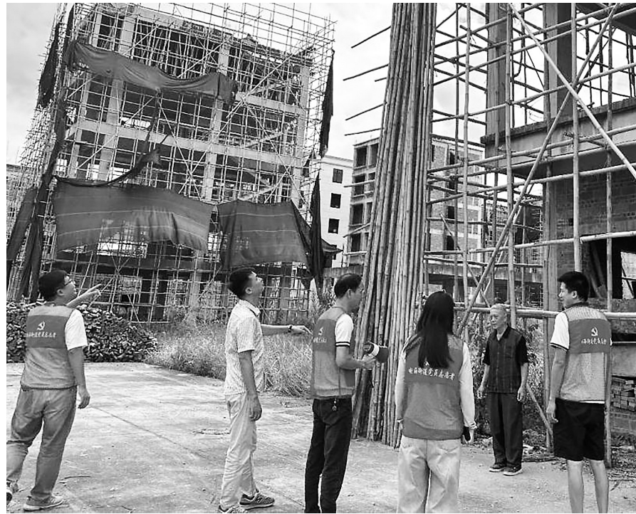
党员干部巡查建筑工地，排除安全隐患。
