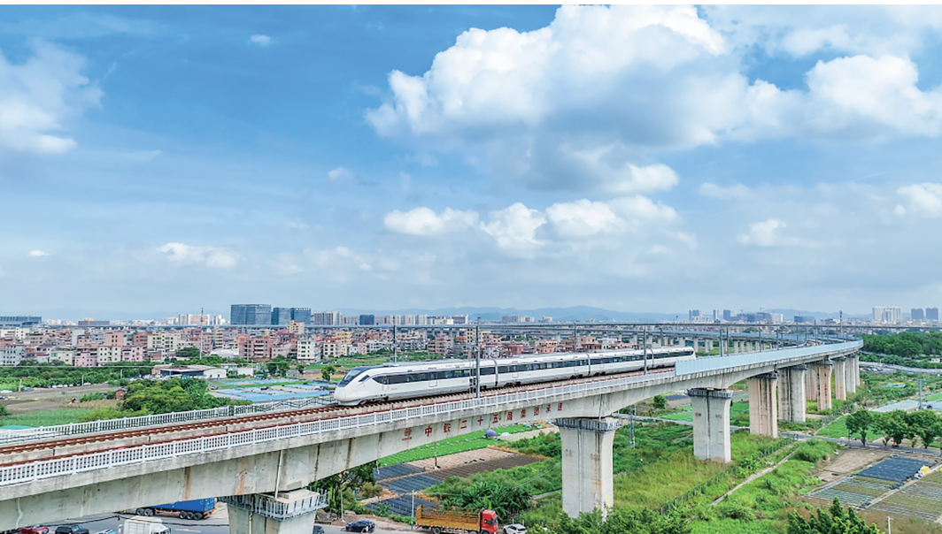
广州东环城际列车行驶在白沙特大桥上。(中铁二十五局供图)
