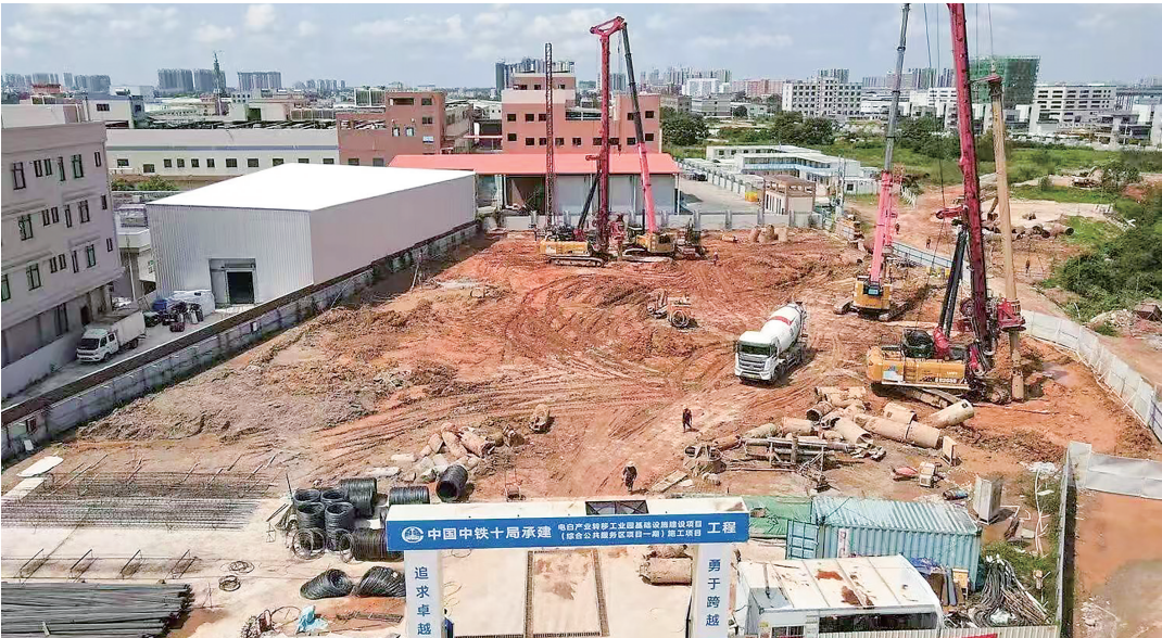
电白产业转移工业园基础设施建设项目(综合公共服务区项目一期)施工现场。通讯员 杨腾飞 摄
