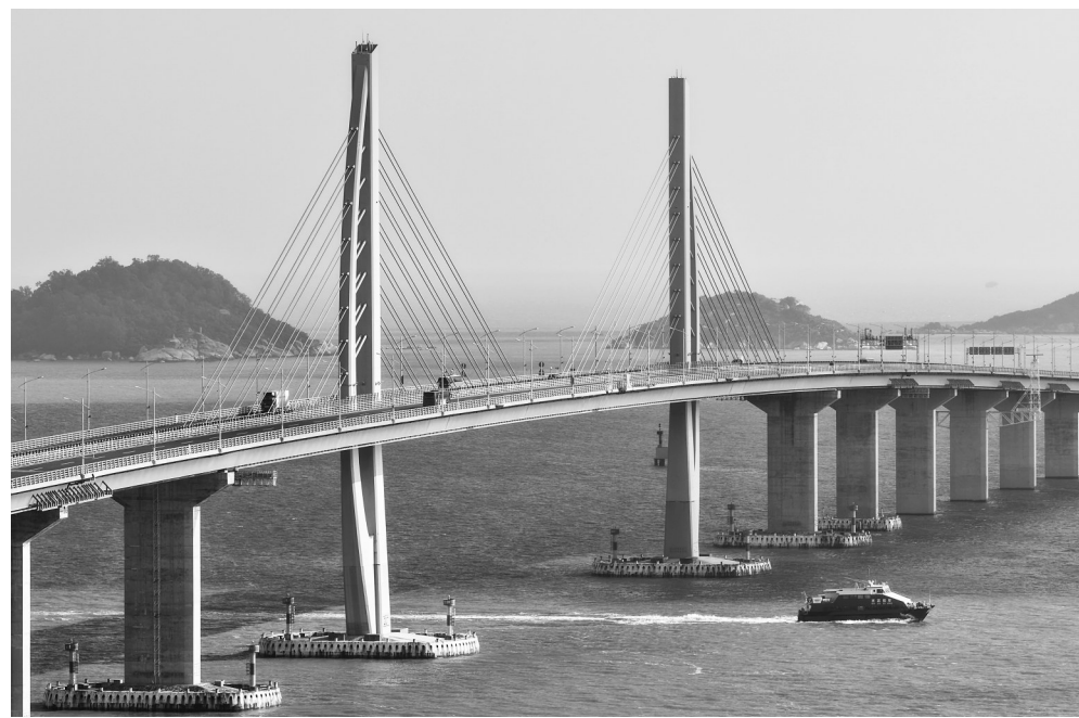
客船驶过港珠澳大桥九洲航道桥（10月19日摄，无人机照片）。新华社记者 邓华 摄
