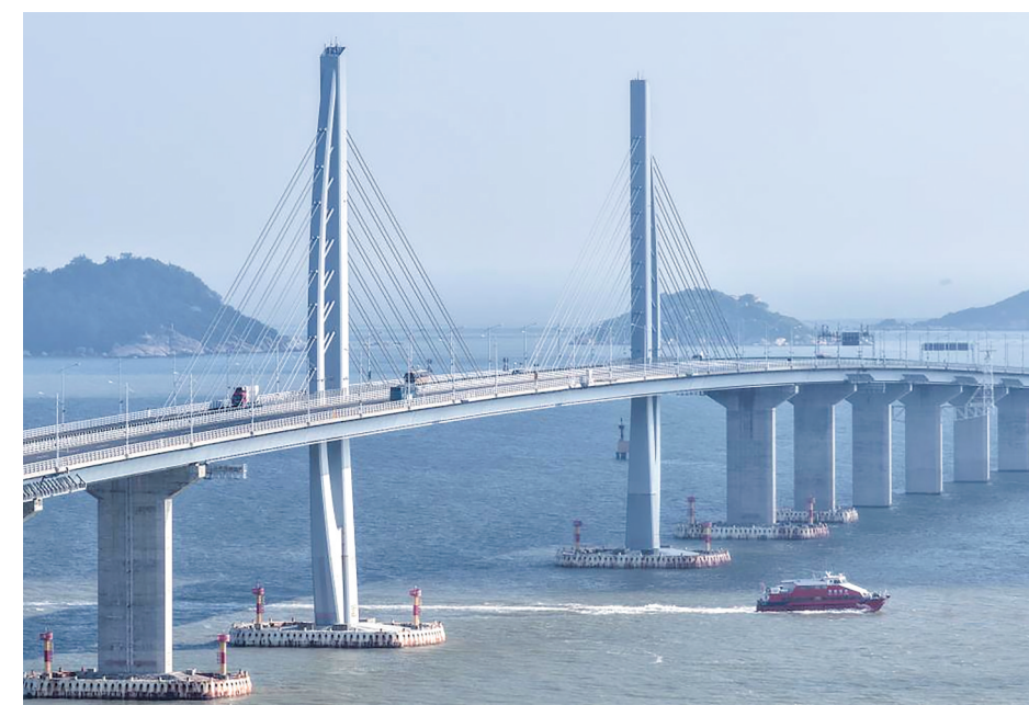
客船驶过港珠澳大桥九洲航道桥。新华社记者 邓华 摄
