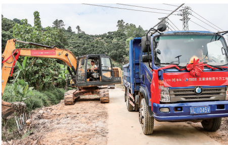
项目施工现场。
