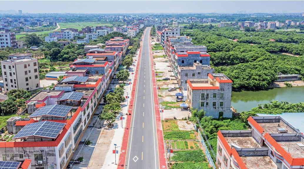
分界镇“三重四沿”农房风貌外立面提升村貌。
