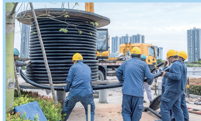
▲在奥体中心公用配电站门口,工作人员正在敷设电缆。
