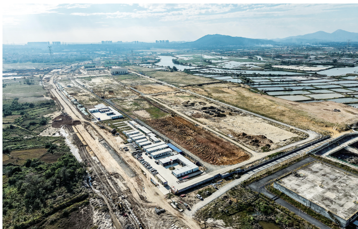
丙烯酸产业园项目位于零碳产业园内。
