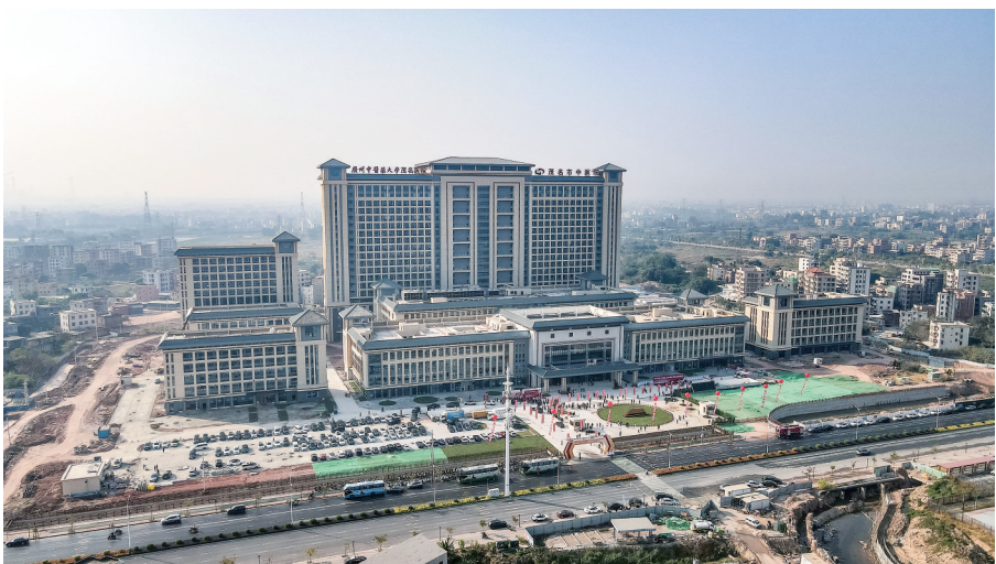
茂名市中医院新院区航拍。
