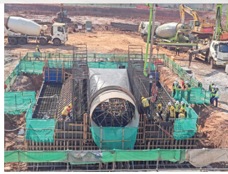
龙门泵站首仓混凝土顺利浇筑。
