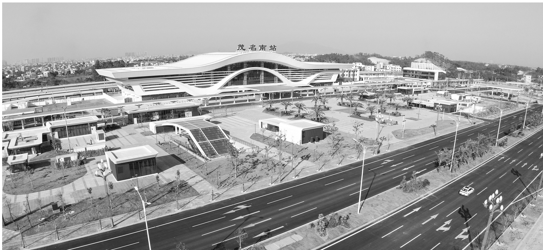
广湛高铁茂名南站。茂名日报社全媒体记者 甘杨松 摄
