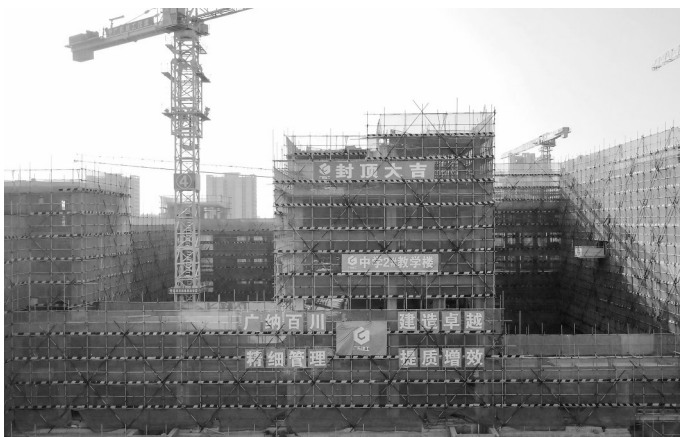
趣园中小学项目主体结构全部封顶。
