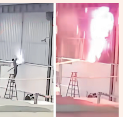
▲男子违规动火作业未做好风险分析及安全防护引燃周围墙体。
