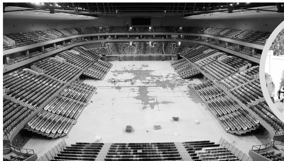
体育馆馆内建设有序推进。茂名日报社全媒体记者 李陶然 摄
