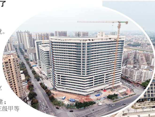
▲ 茂名市人民医院应急大楼项目建设稳步推进。茂名日报社全媒体记者 刘付思明 摄
