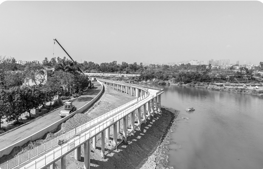
袂花江综合治理工程。茂名日报社全媒体记者 周泽佳 摄
