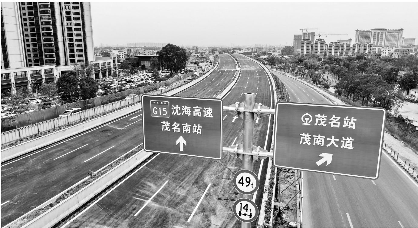
2月9日，茂南大道立交试通车。张波 摄
