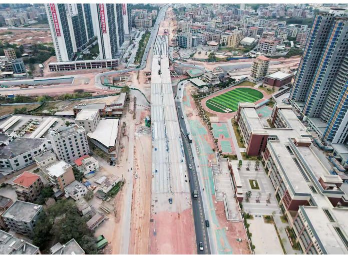
茂东大桥主线贯通。
