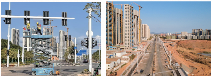
工人安装交通信号灯。
