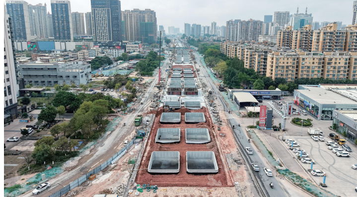
隧道天窗段施工现场。
