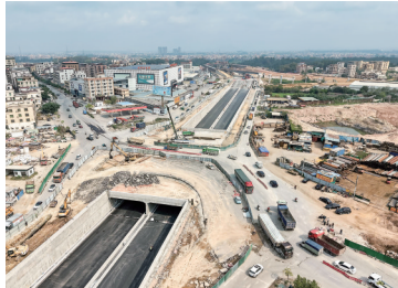
隧道主体实现贯通。
