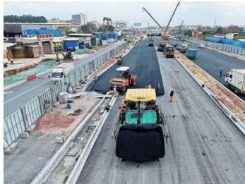
沥青路面铺装。
