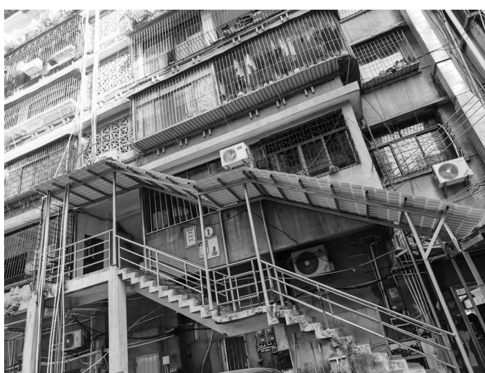
旧雨棚被拆除,崭新坚固的雨棚投入使用。
