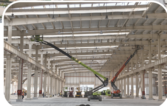
▲工人们在大机械的协同配合下开展室内机电安装。
