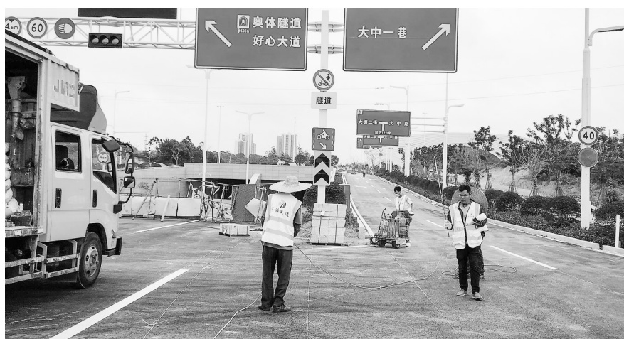
施工人员有条不紊地施划车道交通标识。
