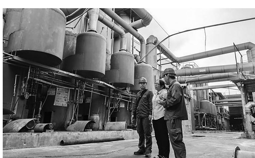
供电人员走进恒裕生物鱼粉生产车间,实地了解企业电力设备运行状况。 通讯员 唐琪森 摄
