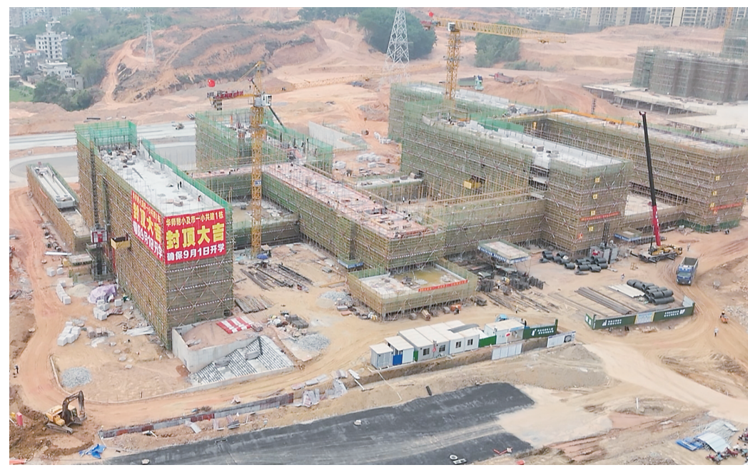
项目所有主建筑均已封顶。
