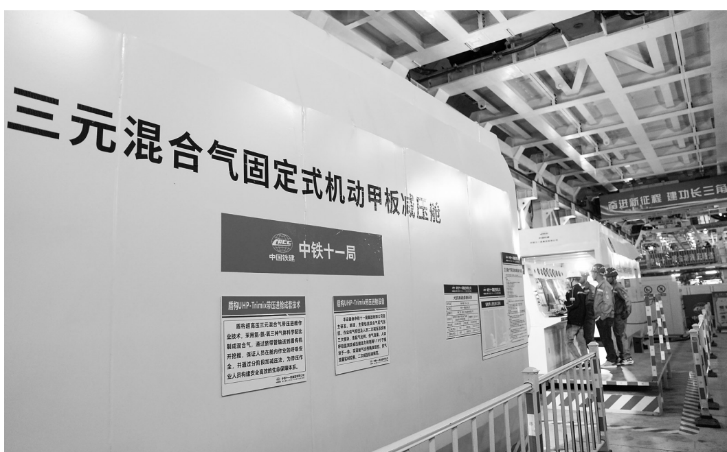
中铁十一局工程技术人员在甬舟铁路金塘海底隧道舟山侧操作“三元混合气”盾构带压作业装备。新华社记者 黄宗治 摄
