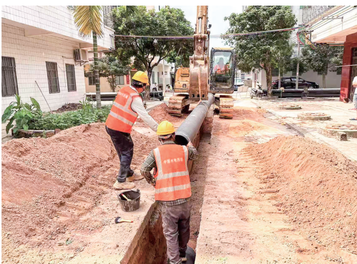
施工人员正在铺设供水管道。
