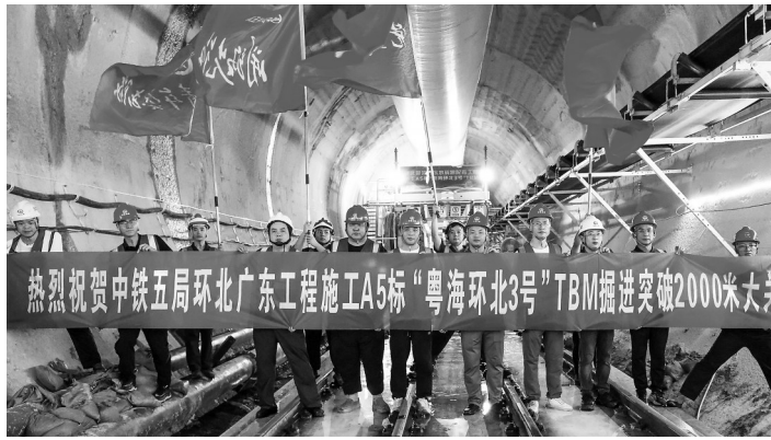
中铁五局环北广东工程“粤海环北3号”TBM掘进突破2000米大关。
