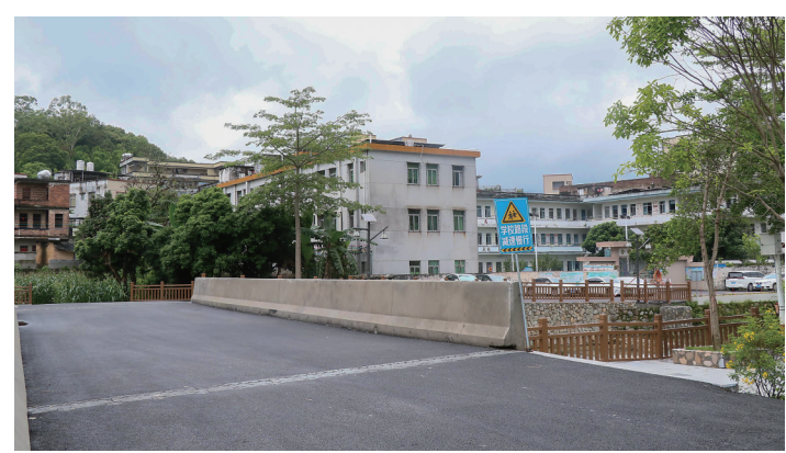
新建的钢筋混凝土桥梁稳稳地横跨两岸。
