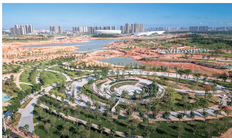
项目建设现场。
