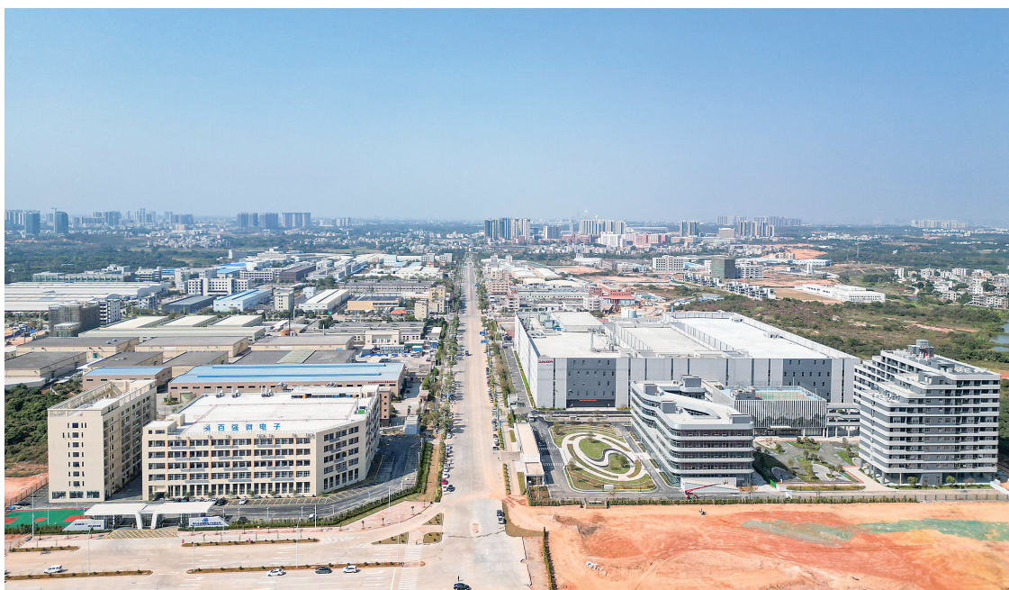
马店河新型储能产业园。通讯员 何伟摄
