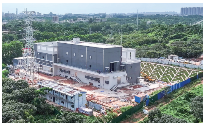
110千伏共青河输变电工程。通讯员 刘志军 摄
