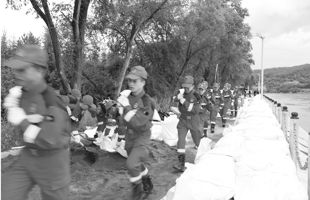
黑龙江消防救援机动总队哈尔滨支队消防员在牡丹江市西安区温春镇江段的防洪堤坝上装填砂石袋,加固大堤。
