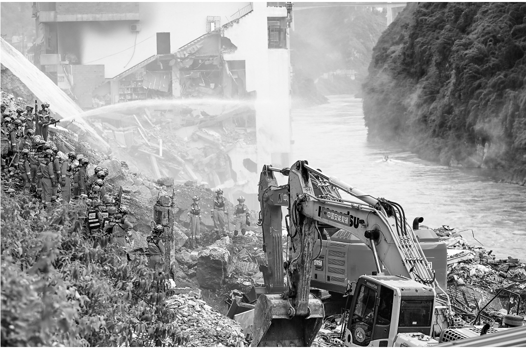
7月17日,救援人员在重庆彭水县山体崩塌现场救援。 新华社记者 王全超 摄
